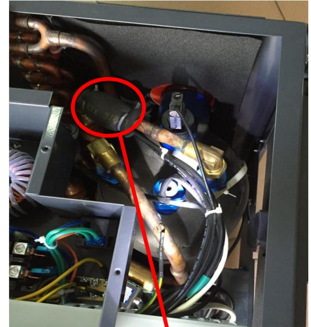
Prüfen, ob die Verdrahtung des Temperaturfühlers für die Kühlrohrschlange richtig angeschlossen ist.
