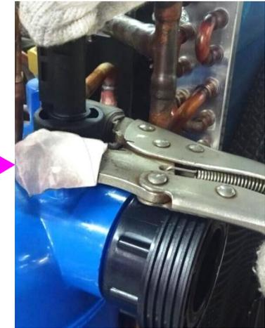
Senkrecht halten, den Wasserdurchflussschalter mit einer Zange fest schrauben.
