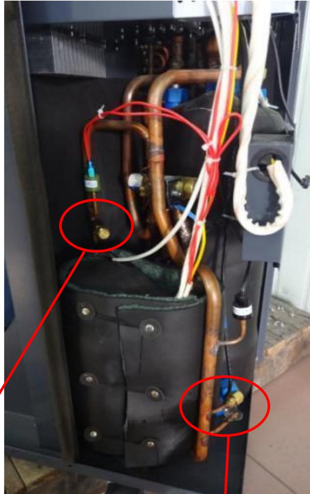
Verdichtergasauslassanschluss ist für Hochdruckerkennung
